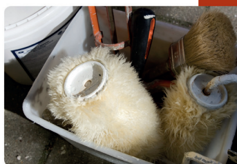
Mangler og følgeskader ved malearbejde
